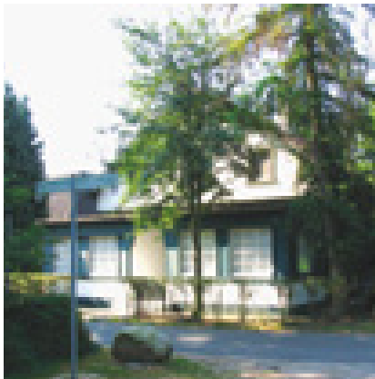
Der ehemalige Bahnhof am Borgfelder Deich heute ...
